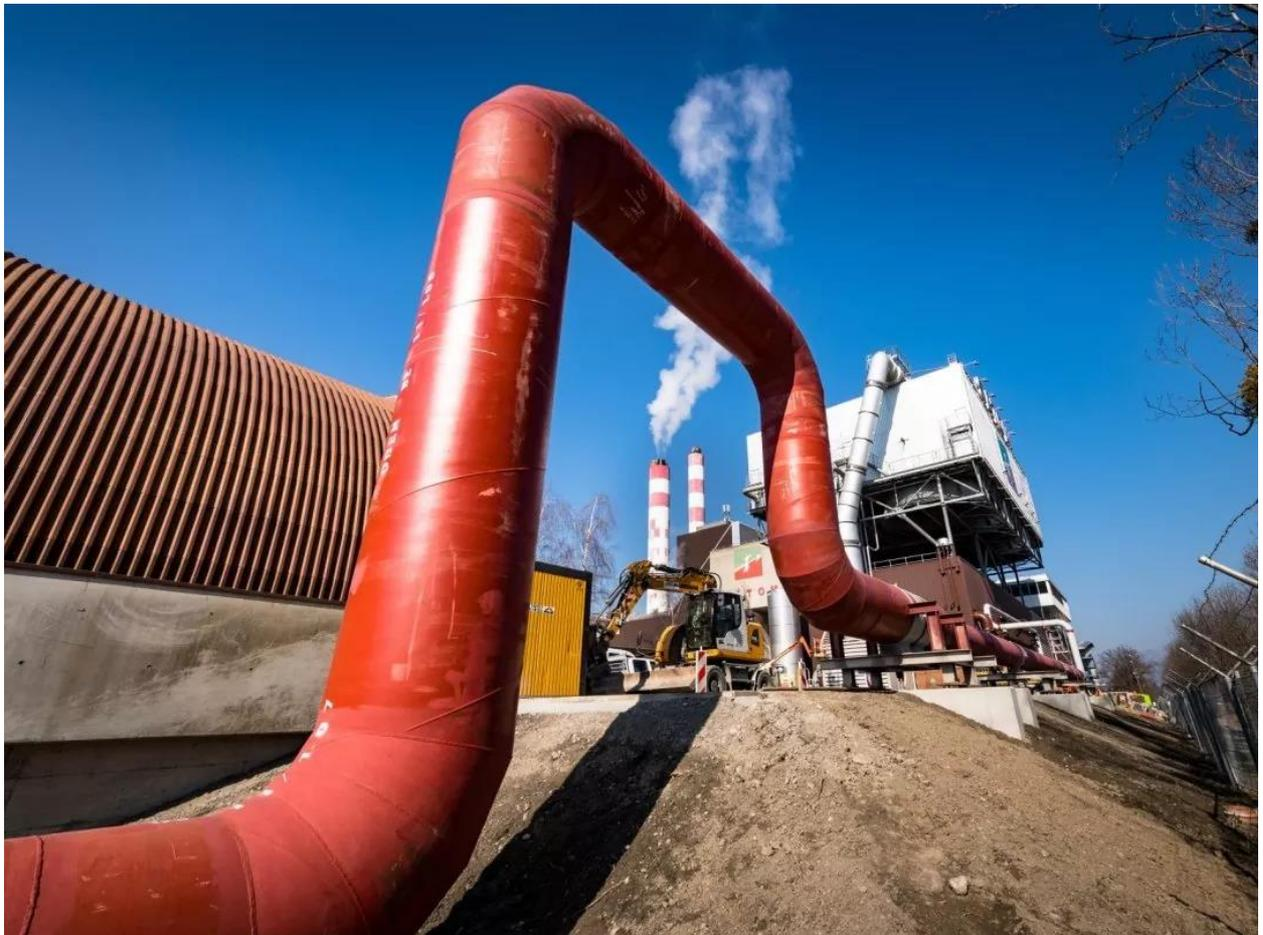
Abbildung 1: Die neue Dampfleitung Ecotube der Satom (KVA Monthey) wurde 2022 in Betrieb genommen. Die Satom versorgt damit den Chemiebetrieb CIMO mit Dampf. Im Jahr 2023 wurde eine Energiemenge von über 110 GWh geliefert. (Bildquelle: Le Nouvelliste).
