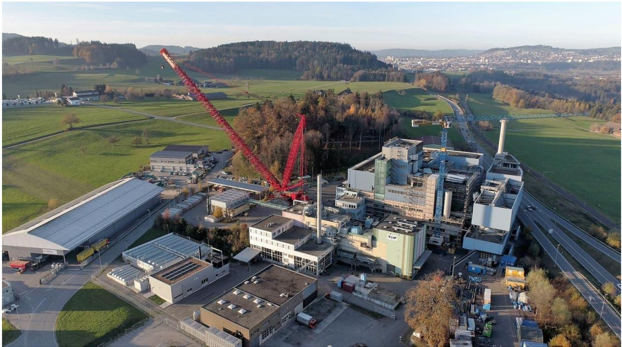
Abbildung 1: Die KVA Bazenheid wurde ein den letzten zwei Jahren erheblich erneuert: Die Verbrennungslinie 3 wurde komplett ersetzt (Feuerung/Kessel) und bei allen drei Linien wurde eine trockene Rauchgasreinigung in Betrieb genommen. Die Verbrennungskapazität wurde um rund 30'000 t/a erhöht. (Bildquelle: Thurgauer Zeitung).
