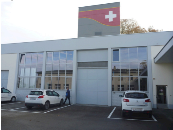
Abbildung 1: Heizzentrale EG auf dem Waffenplatz Bure. Trotz räumlicher Beschränkung konnte ein betrieblich durchdachtes Aufstellungskonzept für die neuen Kessel gefunden werden.
